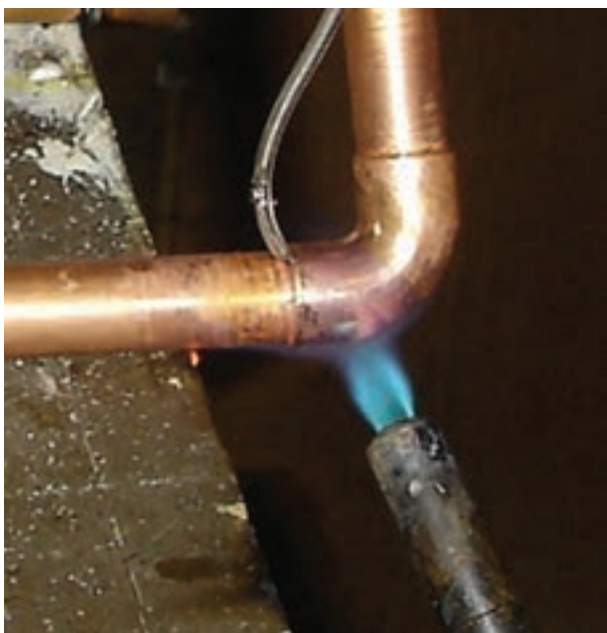
شکل ۱-۵- اتصال لوله‌ی مسی با فیتینگ لحیمی
