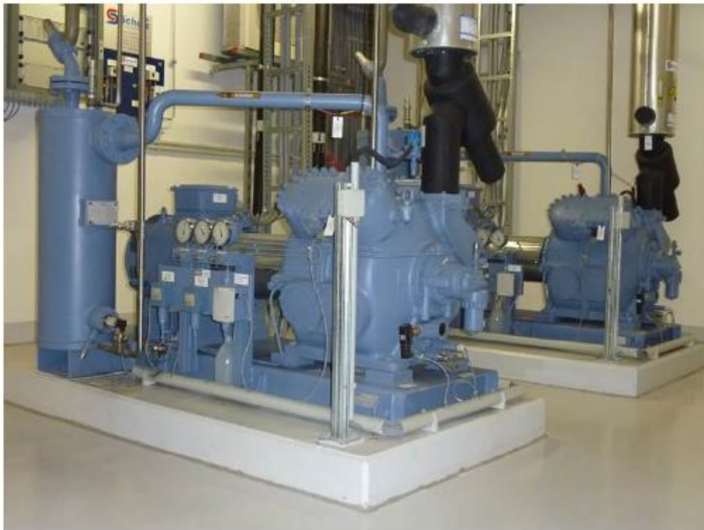
شکل ۳: چیدمان صحیح اتاق کمپرسور
